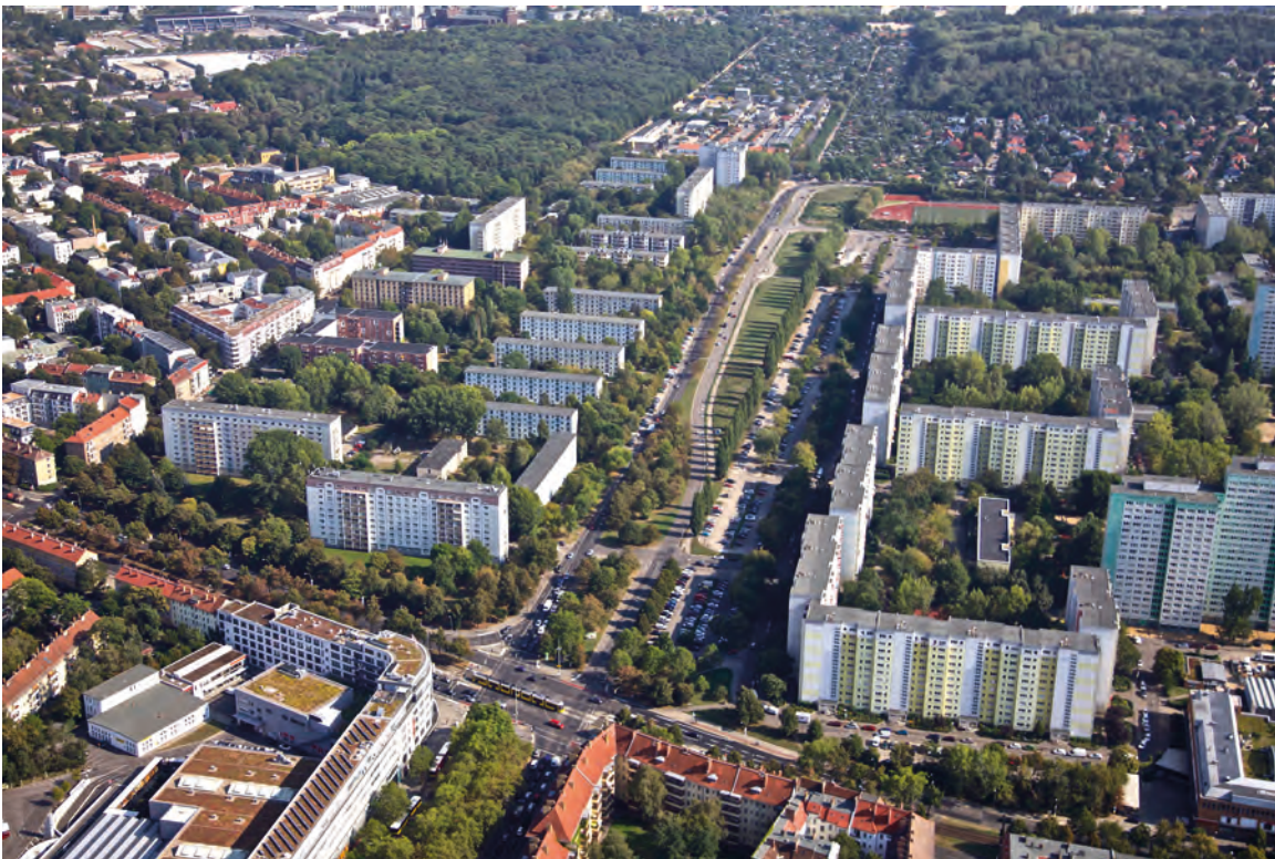
Blick von Westen auf die Michelangelostraße und die umliegenden Gebäude Quelle: Dirk Laubner (Bildrecht), Senatsverwaltung für Stadtentwicklung und Wohnen (Nutzungsrecht)
