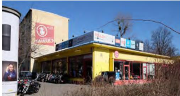
Abb. 3 Planfeld 1: Ehemalige Kaufhalle, Blick von der Prenzlauer Allee
